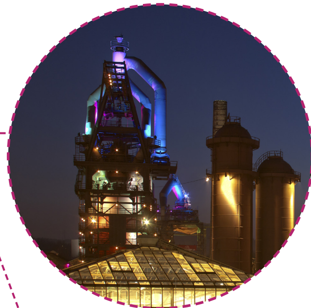
Abb. 23: Hochofen im Alten Hüttenareal, Neunkirchen
