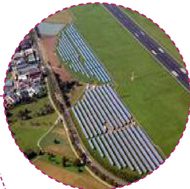
Abb. 28: Solaranlage Flughafen Saarbrücken
